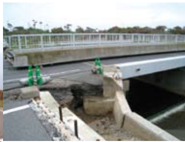
旭市の九十九里自転車道・日の出橋は、津波で橋が持ち上がり、アスファルトもえぐれてしまいました。
