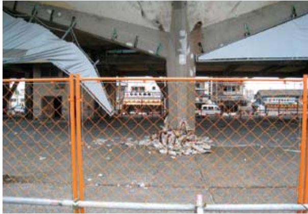
銚子漁港の荷捌場では地震の揺れにコンクリの柱が崩れて天井が下がり、現在も立ち入り禁止状態です。
